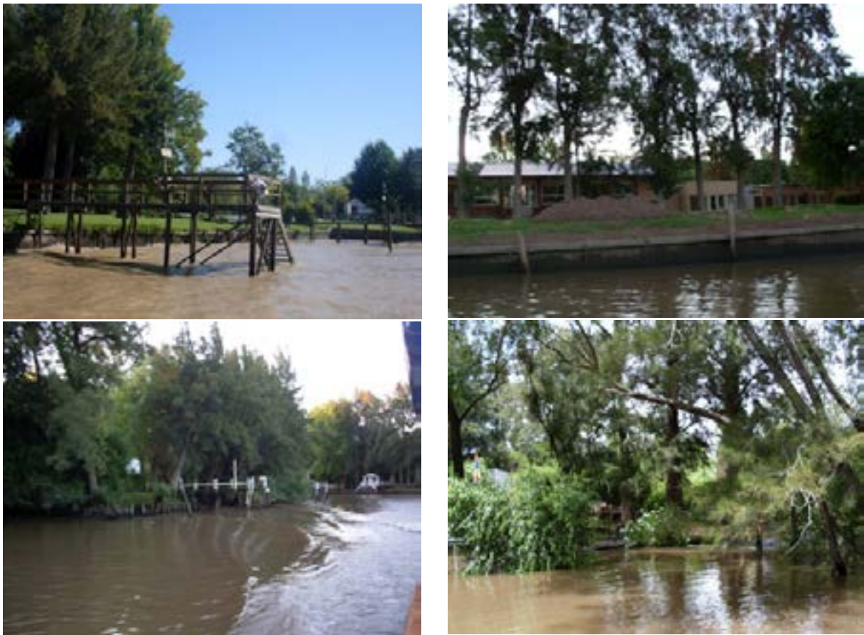
Figura 25: Imágenes del borde costero de algunos sectores de Tigre, con diferentes tipos de defensas, siendo la más eficiente desde el punto de vista ambiental la protección con vegetación natural (abajo a la derecha). Fuente: Manotas, 2012.
